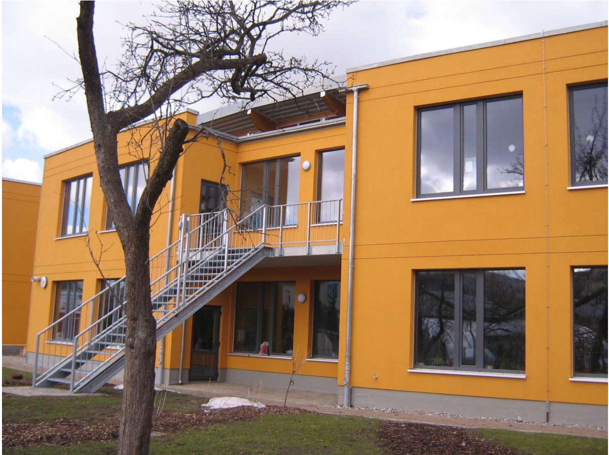
Haus 4 Ansicht Süd Klassenräume
